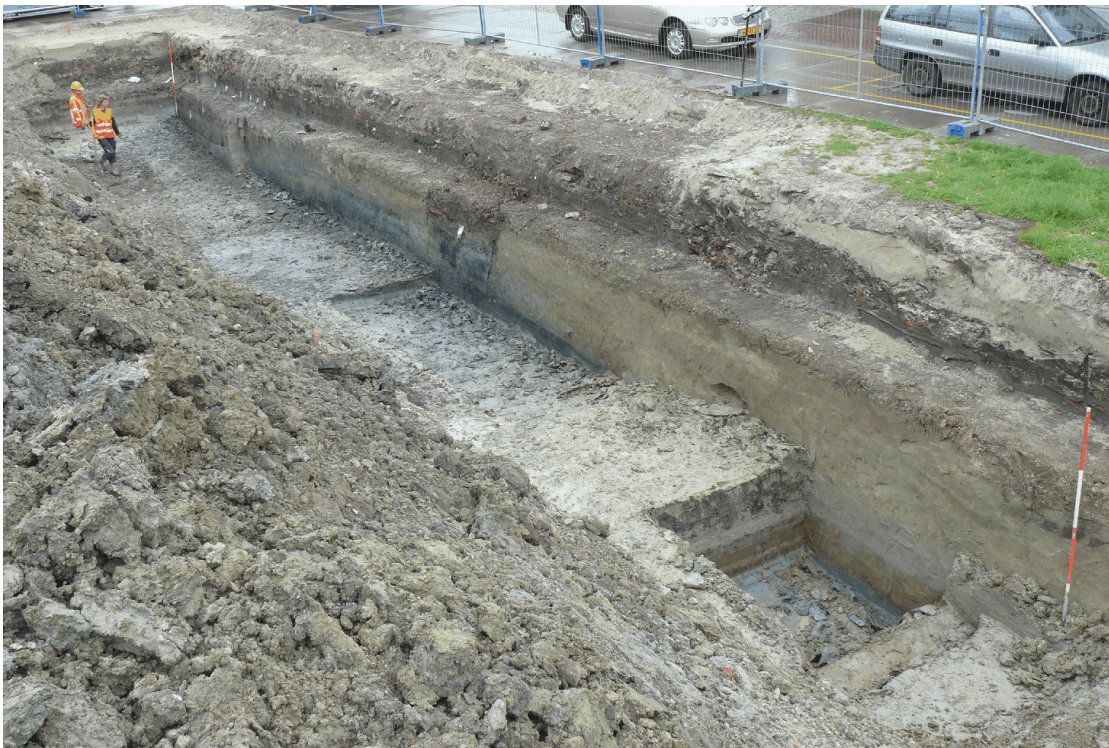
Figuur 12. Winsum, Boogplein: foto van de twee kijkgaten tegen het profiel van werkput 3. De foto is genomen richting het zuidoosten.
