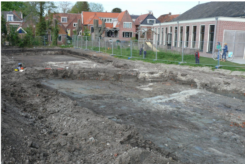
Figuur 7. Winsum, Boogplein: foto van het eerste vlak van werkput 1. Centraal in de werkput is de dam ter hoogte van de rioolbuis te zien die de werkput in twee delen splitst. De foto is genomen richting het noordoosten.
