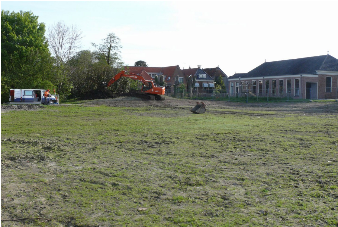
Figuur 3. Winsum Boogplein: het plangebied vóór aanvang van de werkzaamheden. De foto is genomen richting het noordoosten.
